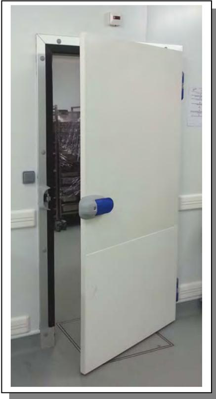
**BATTANT SEMI-ENCASTRE A RUPTURE DE PONT THERMIQUE**
